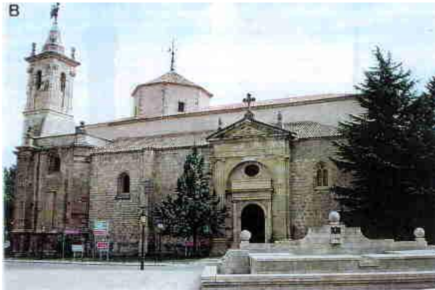
Figura 6. Monasterios y Conventos: A) Monasterio de la virgen de la Hoz (desfiladero del río Gallo, a unos 12 Km de Molina); está apoyado en los conglomerados de la Hoz del río Gallo, de facies Bundsantein, que corresponden al tránsito del Pérmico/Triásico (Ramos, 1979); B) Real Convento de San Francisco (Molina de Aragón). Fot. Goy
