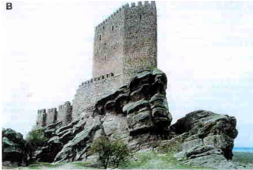
Figura 2. Arquitectura militar del Señorío de Molina: A) Castillo de Molina; B) Castillo de Zafra. Fot. A. Goy
